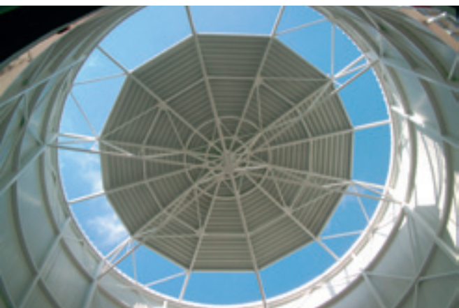
Takkonstruktion målad med färg innehållande Nano-lera. Vid brand omvandlas leran till ett skyddande skikt.
